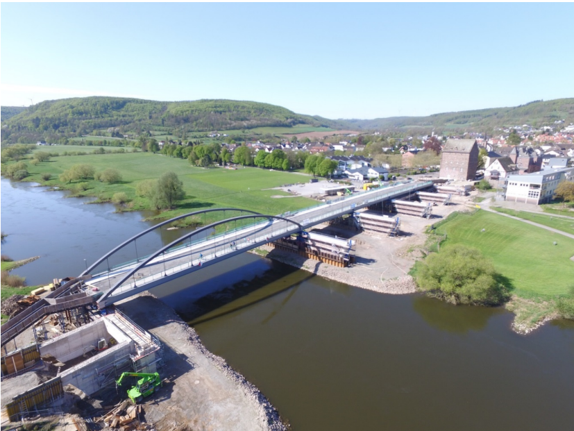
Weserbrücke im Bau 2020
