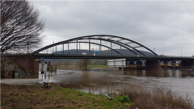
Weserbrücke im Bau 2019
