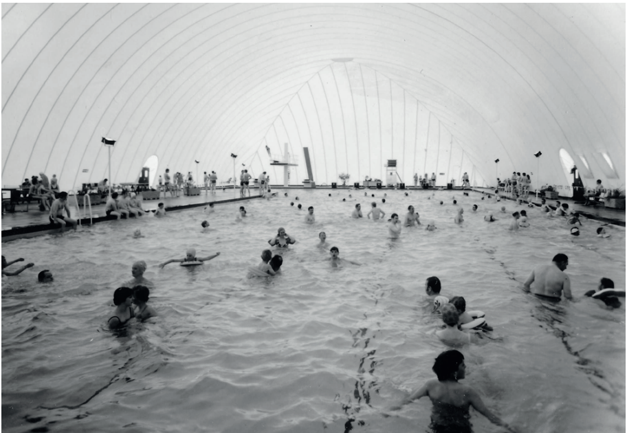
Traglufthalle über Freibad Beverungen
