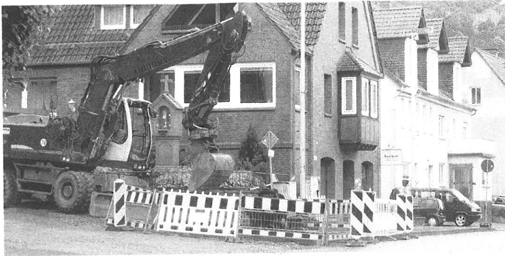
Es wird gebuddelt: An dieser Baustelle wird der Verkehr auf der Bundesstraße 83 einspurig per Ampelschaltung vorbeigeführt.
