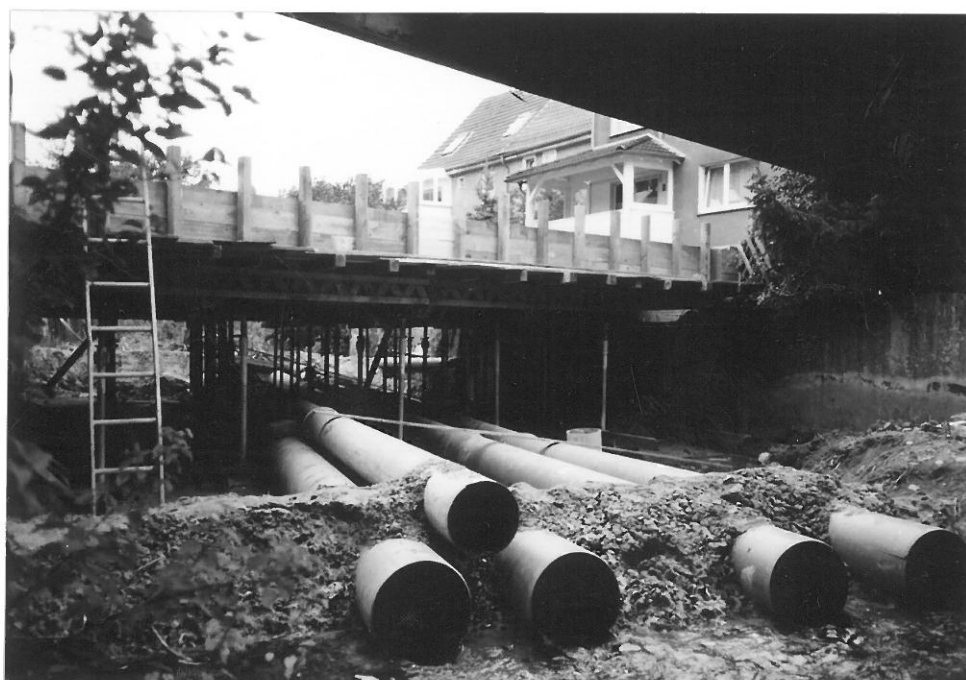
Umleitung der Bever während der Bauarbeiten: mit Ton abgedichtete Stahlrohre!
