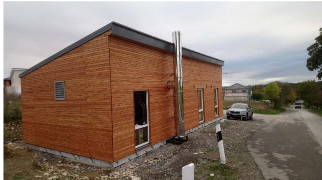
Abb. Heizzentrale in Baugebiet Hessenberg in Borchen
