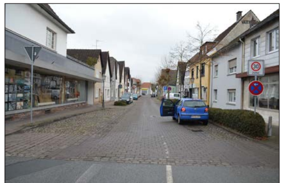
Abb. 17: Mühlenstraße im westlichen Abschnitt an der Langen Straße
