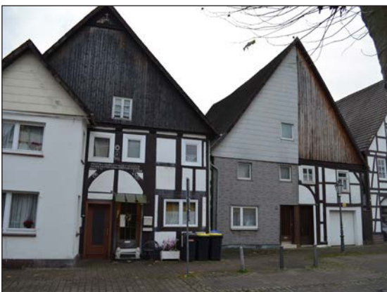
Abb. 35: Fassaden mit Verbesserungspotenzial in der Innenstadt an der Mühlenstraße
