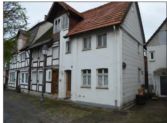
Abb. 31: Mittelstraße 19a + b
