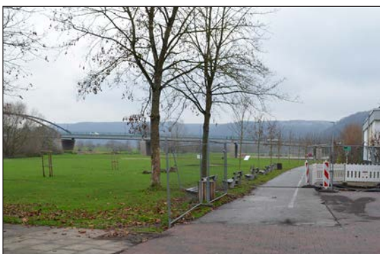
Abb. 56: Aufenthaltsangebote nördlich der Brücke, rechts Weserradweg
