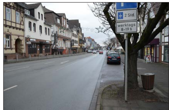
Abb. 27: Mangelhafter Zustand und fehlende Aufenthaltsqualität auf den Nebenanlagen Lange Straße
