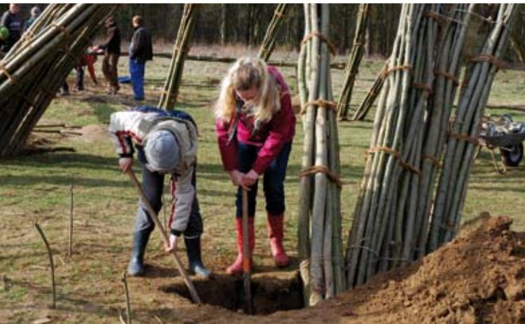
Das Prinzip eines solchen Baus ist einfach: Bündel aus Weidenruten werden in die Erde eingegraben, zu kuppelartigen Trägern geformt und stabilisiert. Danach wird die Natur zum Bauherrn: Sie lässt den Baustoff Holz direkt ins Bauwerk wachsen.
