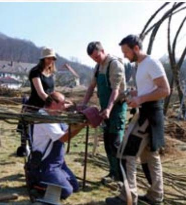
Ausschließlich in Handarbeit wurden dann die Ruten mit Seilen zusammengebunden und gebogen. Damit die Rutenbündel in Form bleiben, tragen sie im Innern ein Eisengerüst. Nach und nach entstanden so die einzelnen Bauteile für das Weidenpalais.
