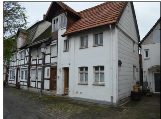
Abb. 21: Mittelstraße 19a + b
