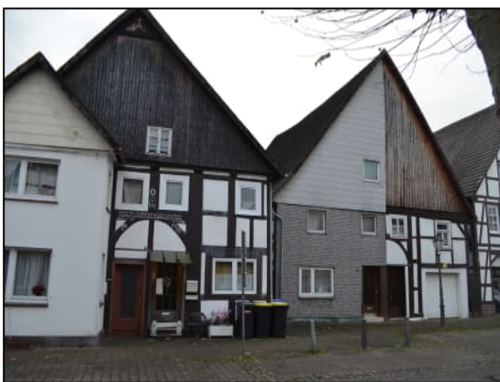
Abb. 29: Fassaden mit Verbesserungspotenzial in der Innenstadt an der Mühlenstraße
