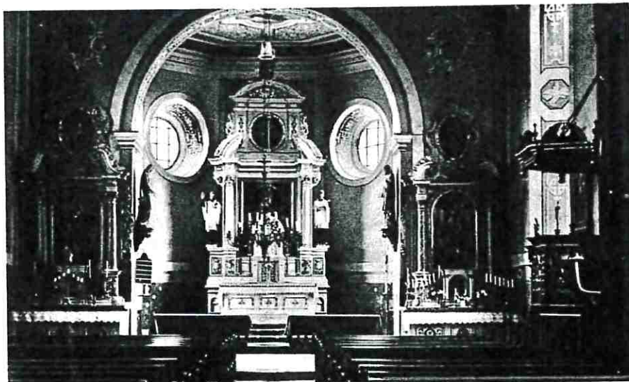
Dalhausener. Inneres der Wallfahrtskirche
