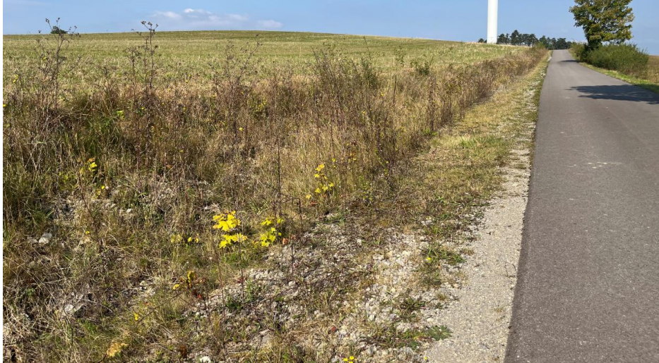
Abbildung 4 Bankette entlang des Wirtschaftsweges im Süden der Vorhabenfläche A2
