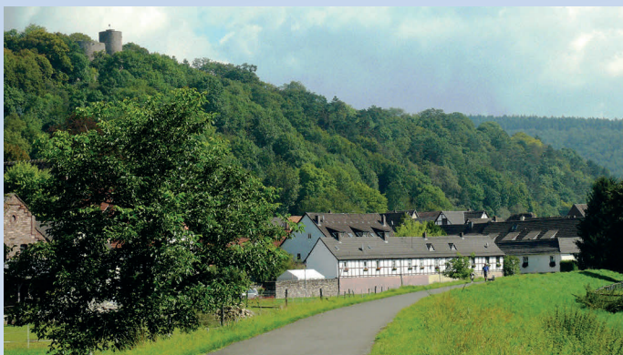
Hochwasserdamm in Helmarshausen
