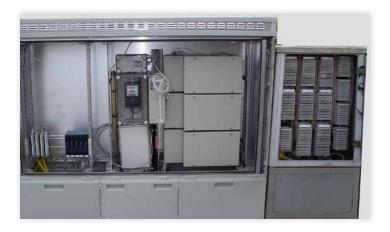
Glasfaserkabel gespeist, sondern bekommt das Breitbandsignal von einem Switch zugeliefert, der das Signal auf mehrere DSLAMs verteilt.
