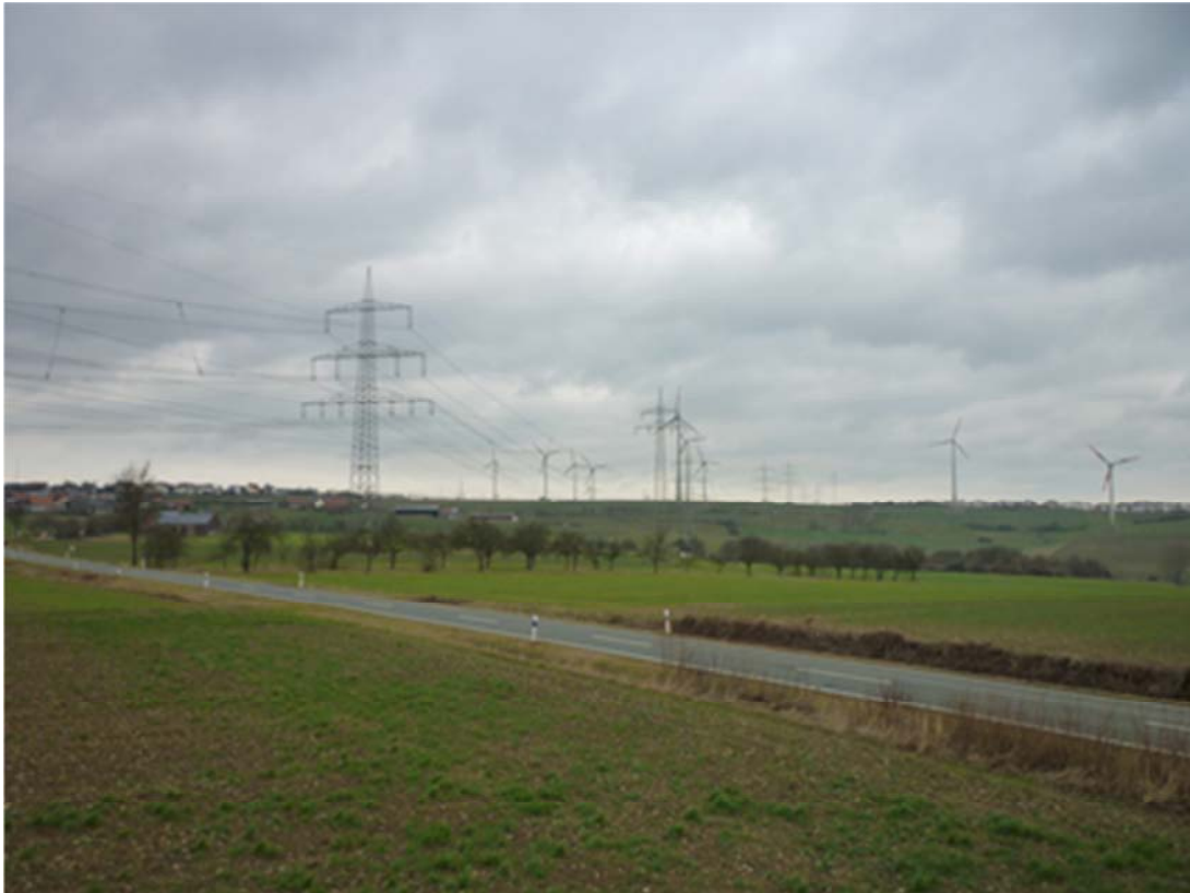
Foto: enveco GmbH, 2014
